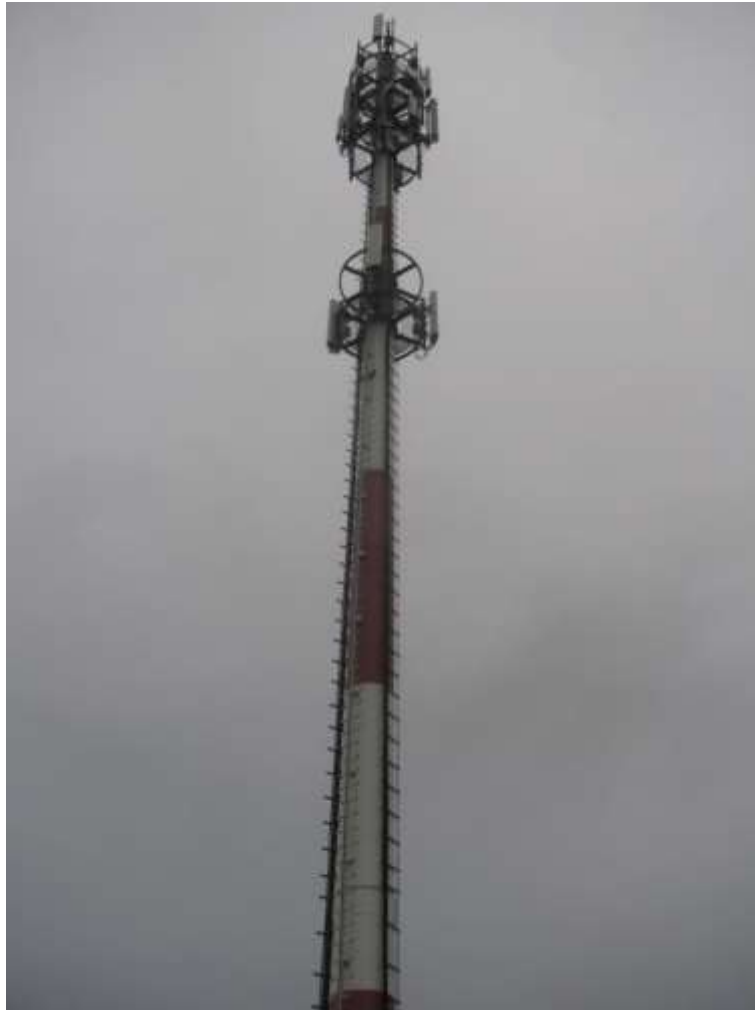
Zał. nr 1: Widok ogólny instalacji radiokomunikacyjnej.
