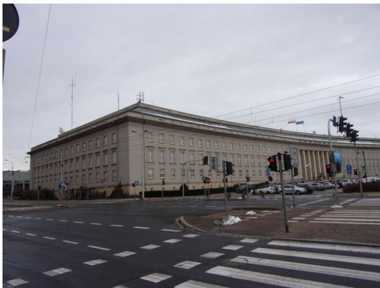
Zał. nr 1: Widok ogólny instalacji radiokomunikacyjnej.
