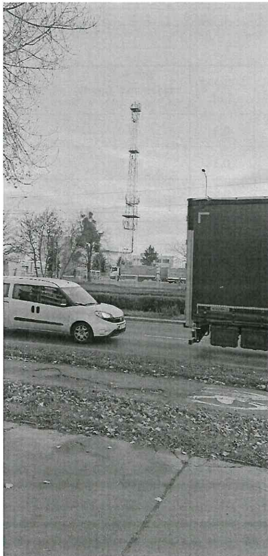
Zdjęcie 1 Badany obiekt
