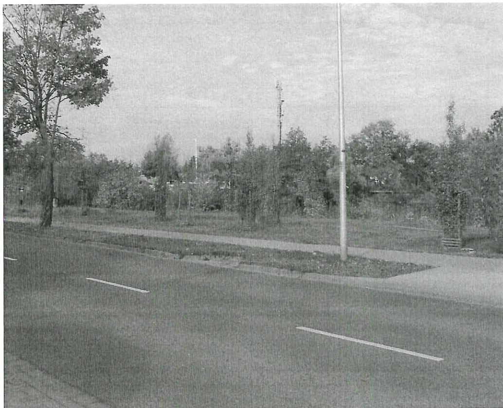
Zdjęcie 1 Badany obiekt
