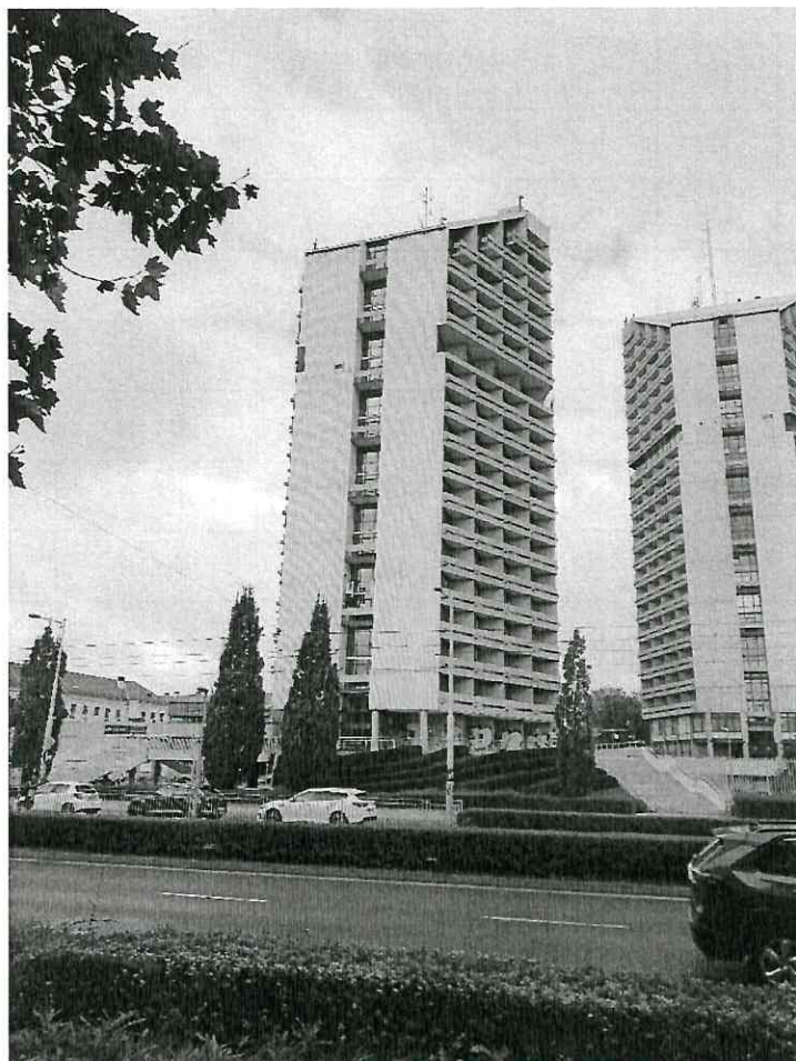
Zdjęcie 1 Badany obiekt
