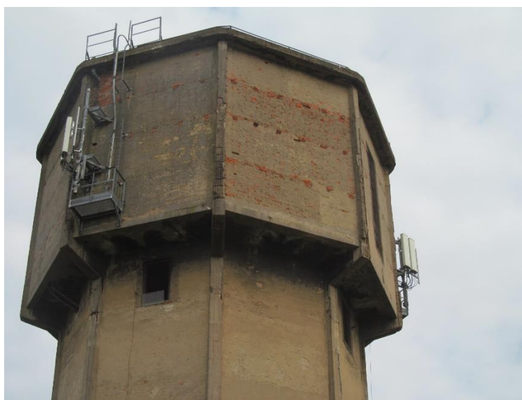
Zał. nr 1: Widok ogólny instalacji radiokomunikacyjnej.
