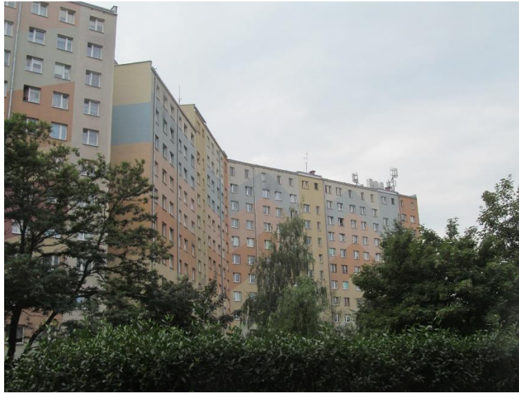
Zał. nr 1: Widok ogólny instalacji radiokomunikacyjnej.
