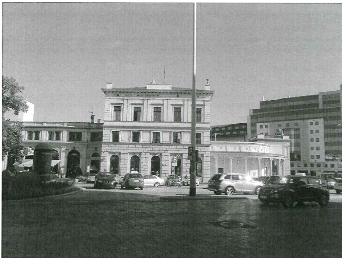
Zdjęcie 1 Badany obiekt
