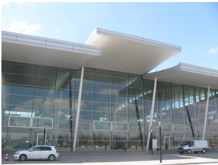
Zał. nr 1: Widok ogólny instalacji radiokomunikacyjnej.
