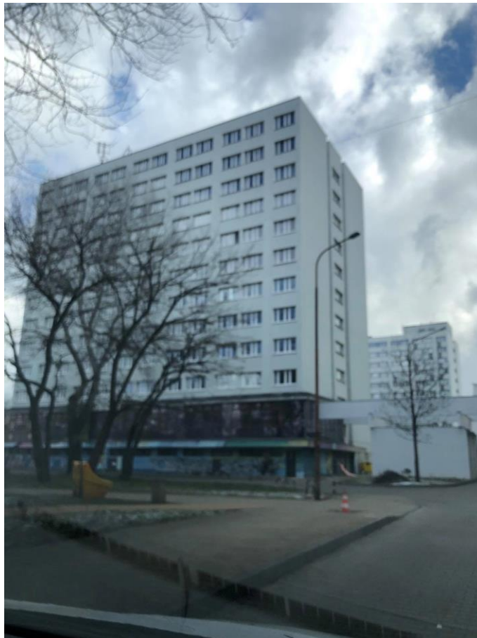
Zał. nr 1: Widok ogólny instalacji radiokomunikacyjnej.
