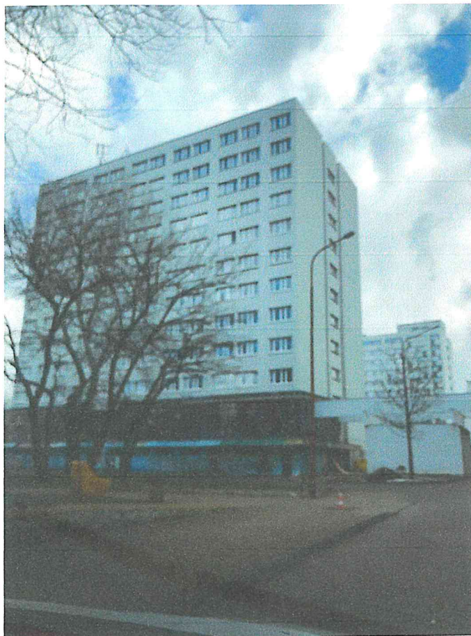
Zal. nr 1: Widok ogólny instalacji radiokomunikacyjnej.
