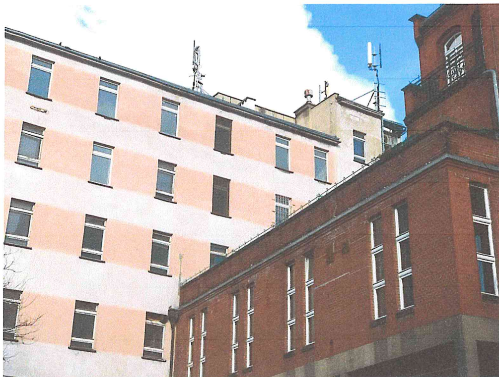
Zał. nr 1: Widok ogólny instalacji radiokomunikacyjnej.
