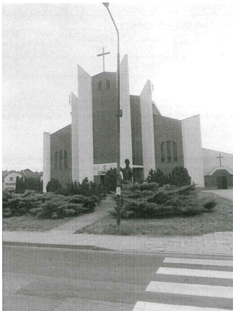
Zdjęcie 1 Badany obiekt
