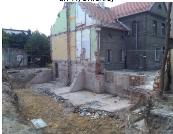
Fot. 14. Rozbiórka budynku przy ul. Rybnickiej
