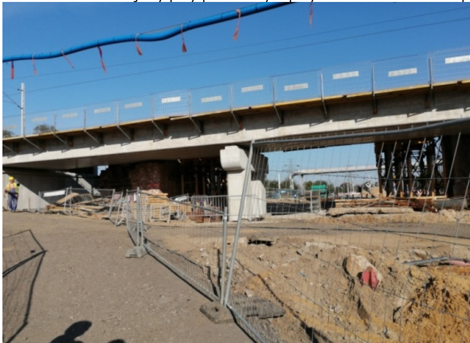
Fot. 45. Wiadukt kolejowy przy planowanym przystanku Wrocław Szczepin
