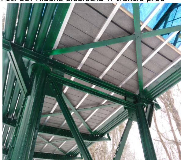
Fot. 55. Kładka siedlecka w trakcie prac
