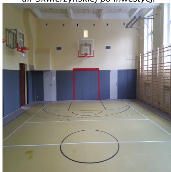
Fot. 33. Sala gimnastyczna T-15 przy ul. Skwierzyńskiej po inwestycji
