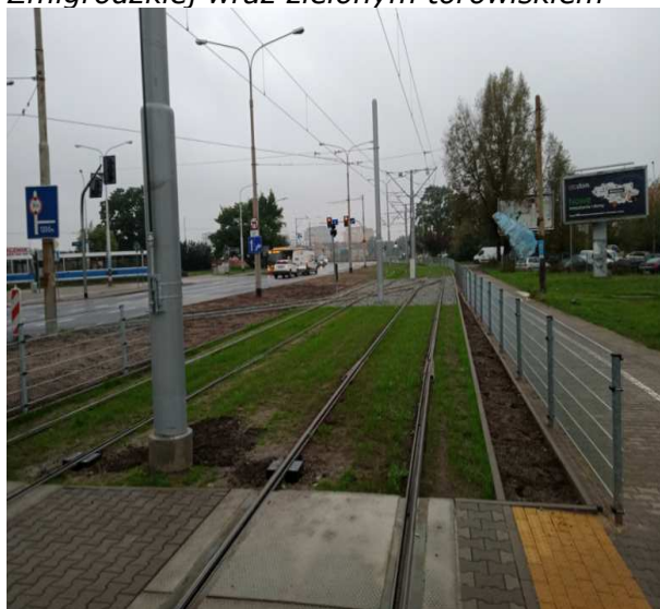
Fot. 58. Remont torowiska w ul. Żmigrodzkiej wraz zielonym torowiskiem
