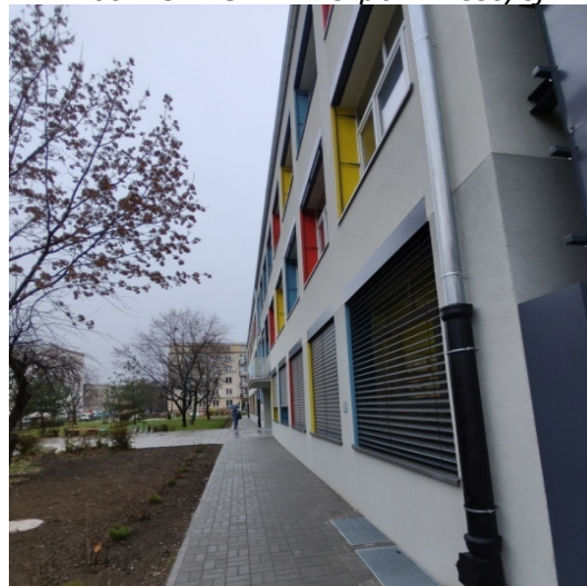
Fot. 25. ZSP nr 13 po inwestycji
