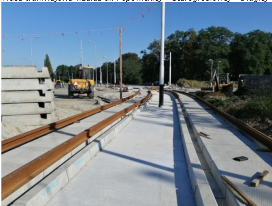
Fot. 44. Trasa tramwajowa wzdłuż ul. Popowickiej – Starogrobłowej – Długiej – etap IA
