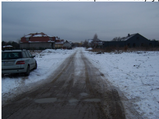
Fot. 3. ul. Pakosławska przed inwestycją
