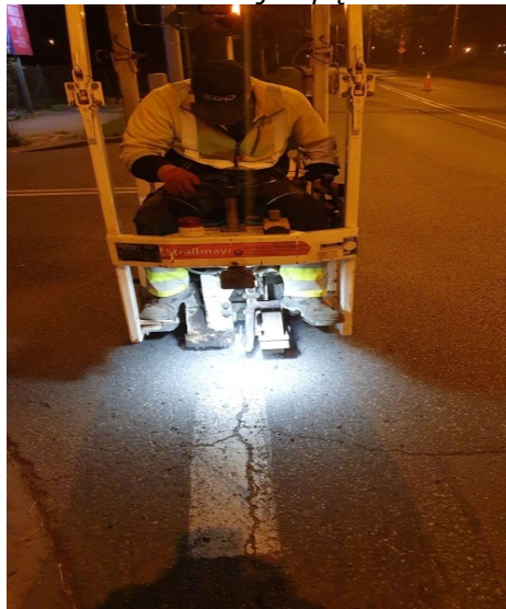
Fot. 52. Likwidacja spękań bitumicznych
