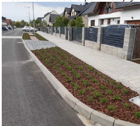
Fot. 2. ul. Lubelska po inwestycji
