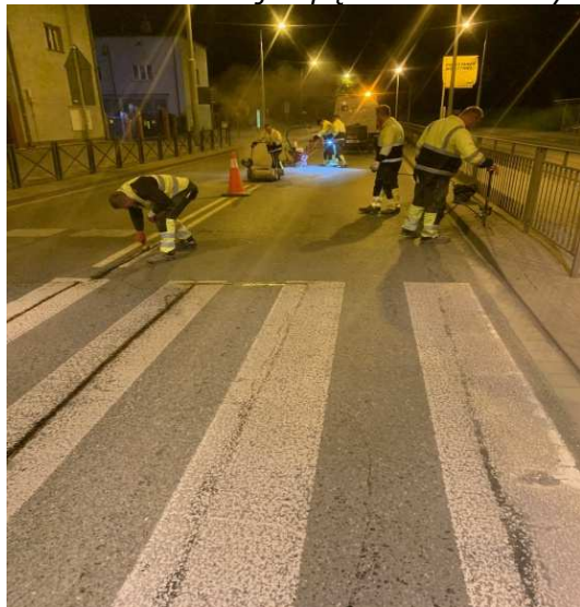
Fot. 51. Likwidacja spękań bitumicznych
