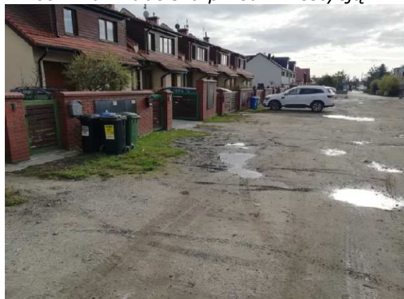
Fot. 1. ul. Lubelska przed inwestycją
