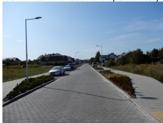
Fot. 4. ul. Pakosławska po inwestycji
