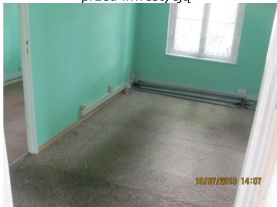
Fot. 12. Budynek przy ul. Bałtyckiej przed inwestycją
