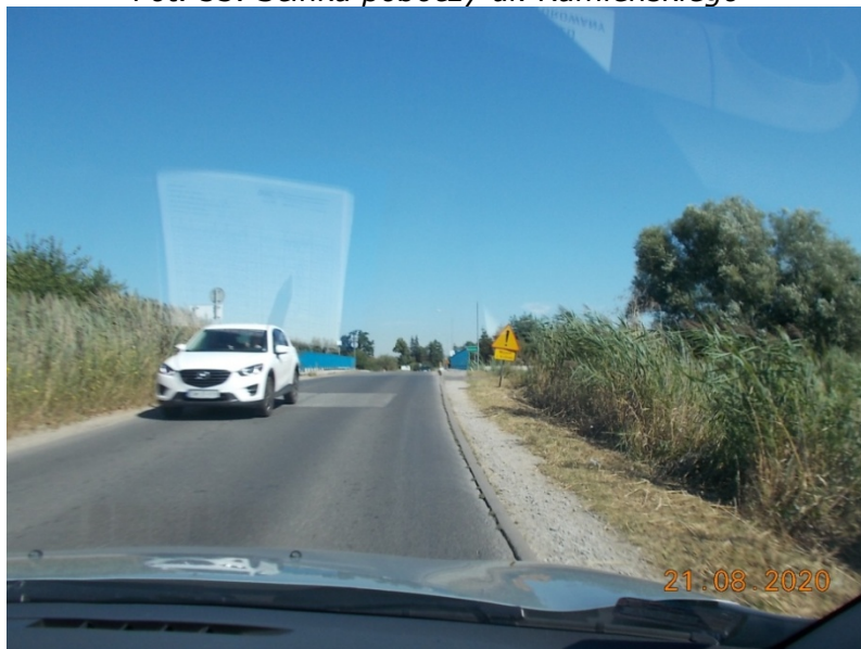
Fot. 53. Ścinka poboczy ul. Kamieńskiego
