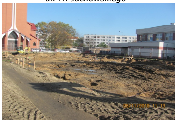
Fot. 28. Teren budowy przedszkola przy ul. M. Jackowskiego
