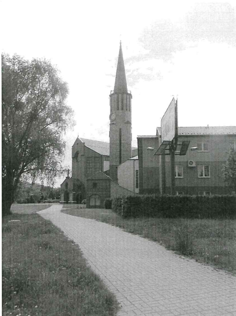
Zdjęcie 1 Badany obiekt
