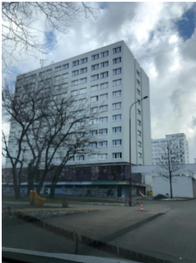
Zał. nr 1: Widok ogólny instalacji radiokomunikacyjnej.
