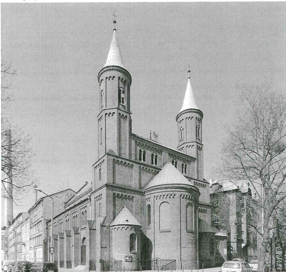
Zdjęcie 1 Badany obiekt
