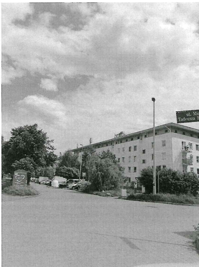
Zdjęcie 1 Badany obiekt
