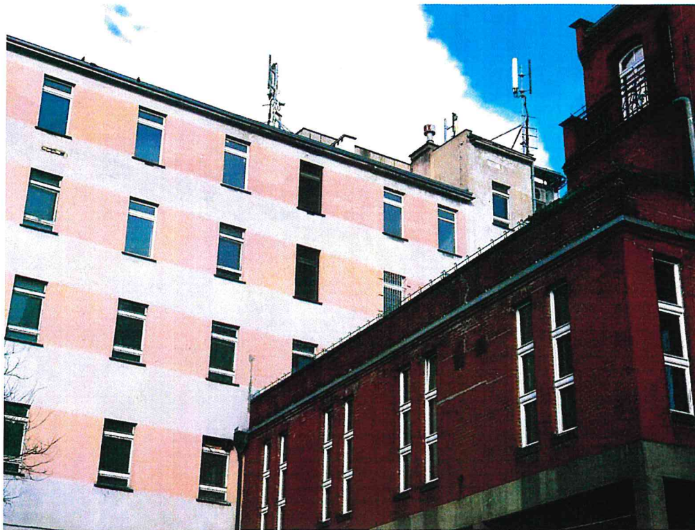
Zał. nr 1: Widok ogólny instalacji radiokomunikacyjnej.
