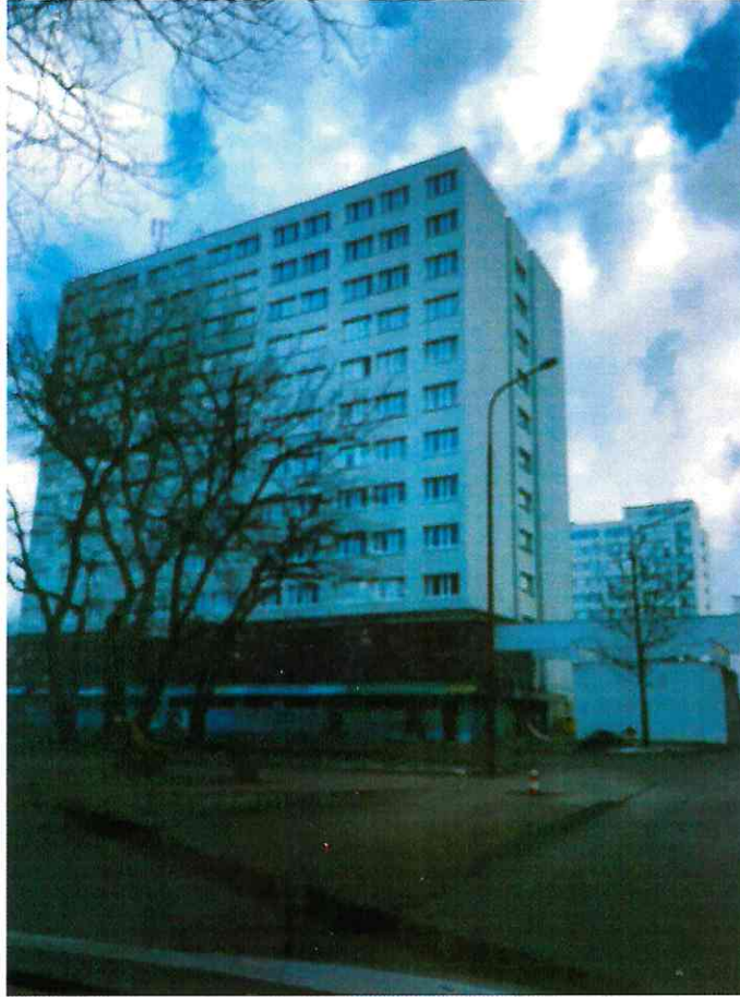
Zał. nr 1: Widok ogólny instalacji radiokomunikacyjnej.
